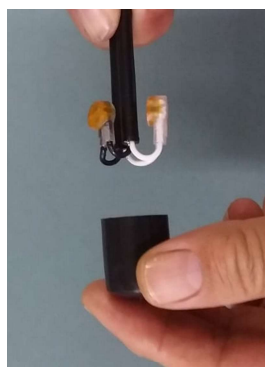
5. Inserir os conectores e preencher o espaço restante.
